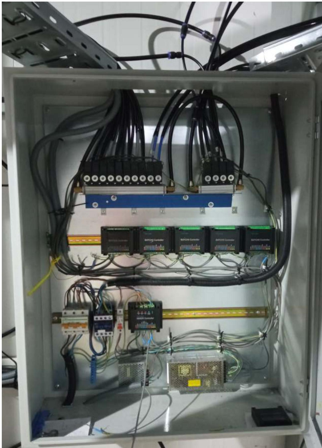
Контроллер Миксера управляет пневмораспределителями цилиндров люков Миксера. Пневмораспределители установлены на монтажной плите, укомплектованной глушителями для устранения или снижения шума сжатого воздуха во время выхлопа. Сжатый воздух подается от сети через фильтр-регулятор. Контроль давления осуществляется манометром. Далее воздух проходит через маслораспылитель. Фильтр-регулятор с манометром и маслораспылитель составляют блок подготовки воздуха.
